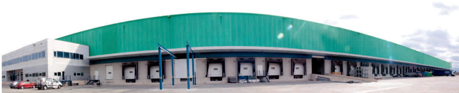
Centro Operativo | Site opérationnel | Operational Centre: Naves 1-2 Logis Bages Onze de setembre 5-19 08650 Sallent Barcelona
